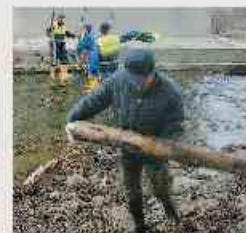
Operazione di pulizia
